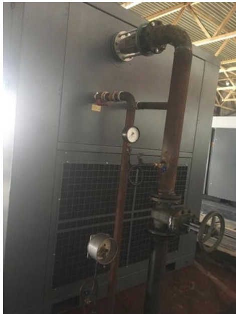
Примеры неправильного монтажа пнев-
